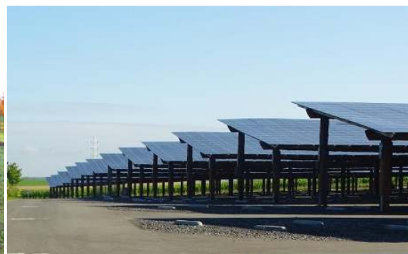
Exemple d'ombrières photovoltaïques - Wikimedia
